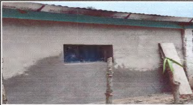
Foto 13: Sustrución de canal de metal
