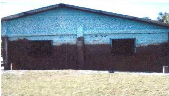
Foto 15: Pintura en muros exteriores e interiores
