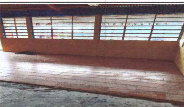
Foto 4: Sustitución de piso cerámico aula y dirección
