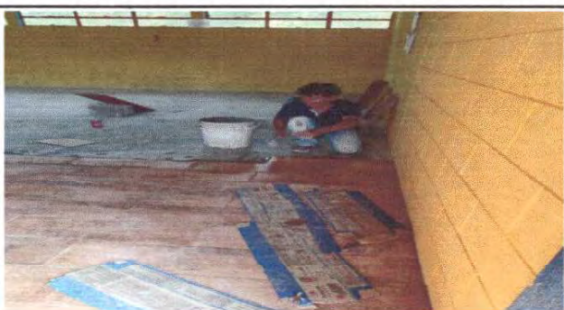
Foto 3: Sustitución de piso cerámico aula y dirección
