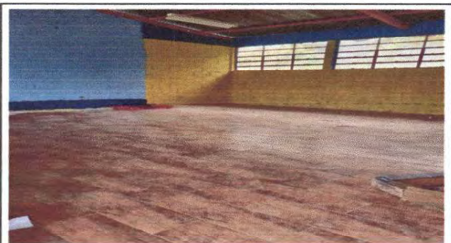
Foto 11: Pintura en muros exteriores e interiores
