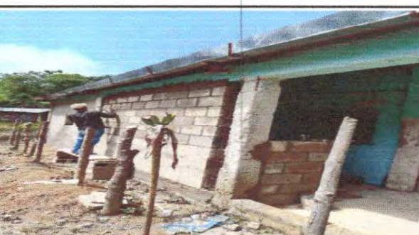
Foto 6: Sustitucion de paredes de lamina por block de dirección
