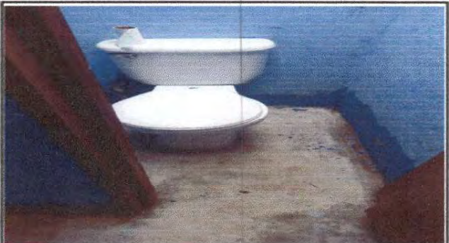
Foto 10: Sustitución de inodoro
