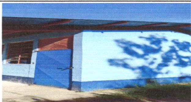
Foto1: Sustitución de puerta
