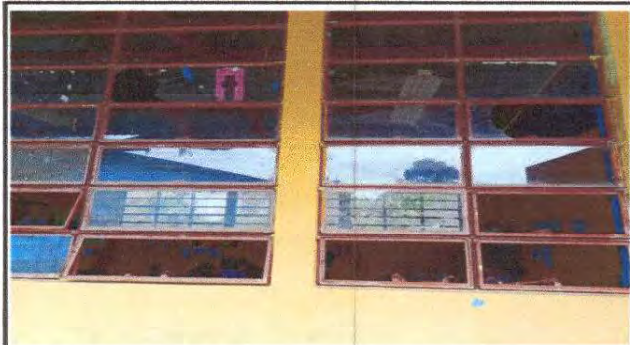
Foto 14: Sustrución de balcones de metal, mantenimiento de estructura de metal de ventanas de vidrio
