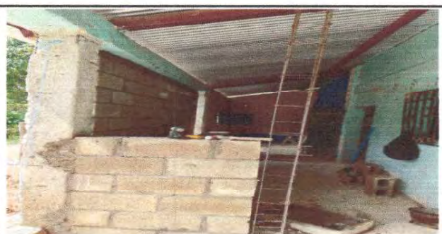
Foto 5: Sustitucion de paredes de lamina por block de dirección
