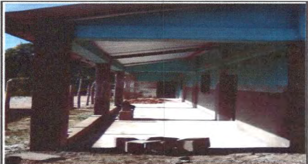
Foto 8: Repello en muro
